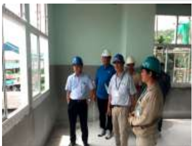
ตรวจสอบความคืบหน้าอาคาร
